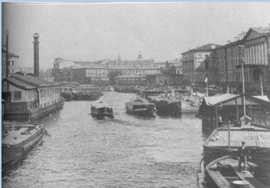
Электростанция на барже. Ф.190. Оп.2-2. Д. 2219. Л.298
