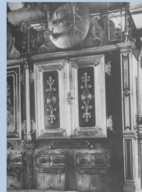
Котельная электростанции Аничкова дворца Ф.190. Оп.2-2. Д. 2219. Л.319
