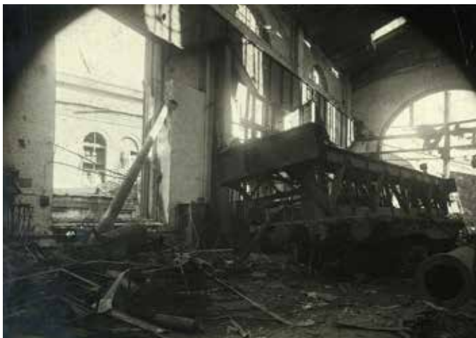
Разрушенный цех завода. 1943 г. ЦГА СПб. Ф. 1275. Оп. 11. Д. 173. Л. 41.
