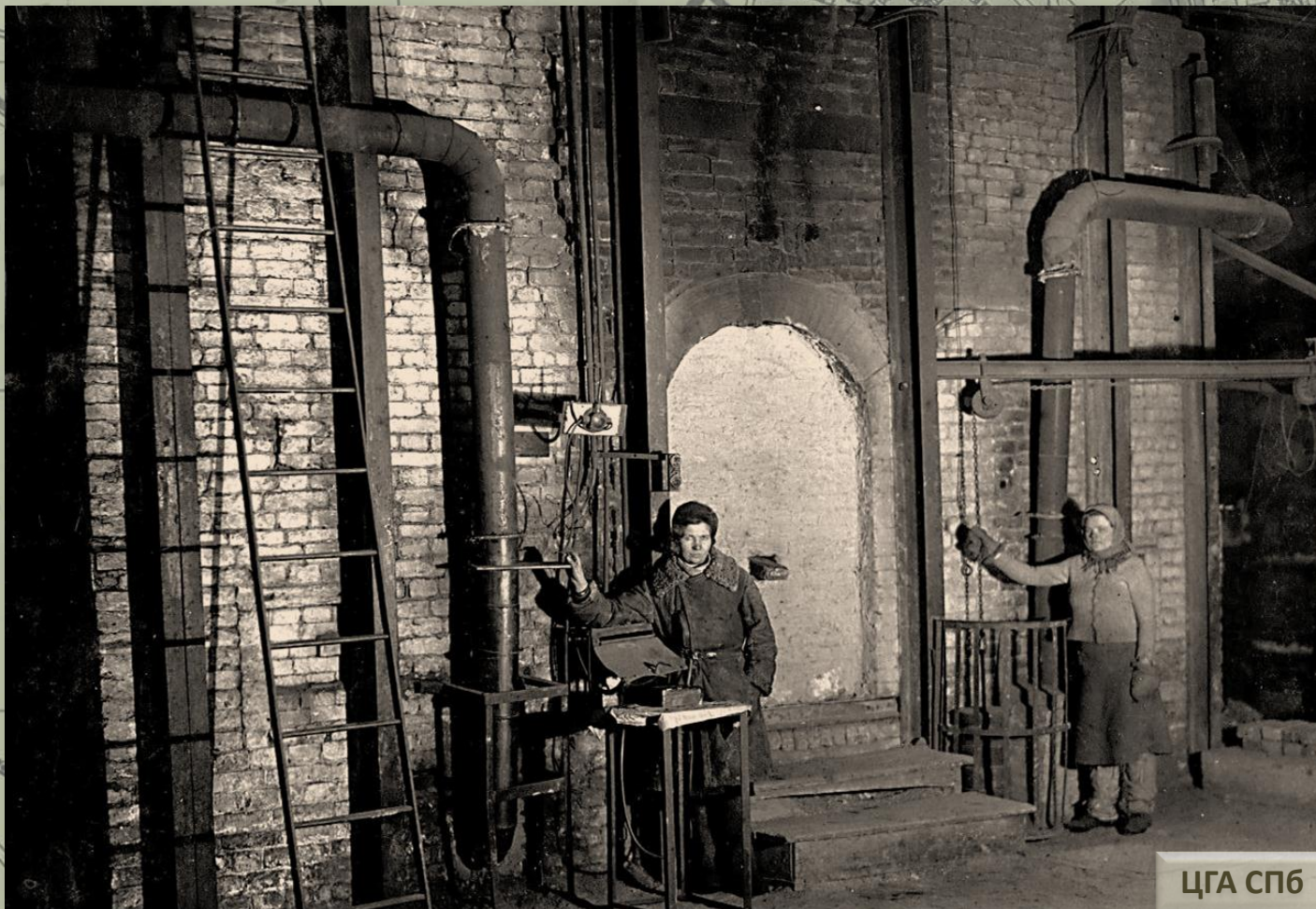
Обжигательная печь № 5. Идёт обжиг кругов для шлифовки шеек коленчатых валов. Обслуживание печей целиком производится женщинами. У печи бригадир Василевская и кочегар Комлева. 1944 г.
